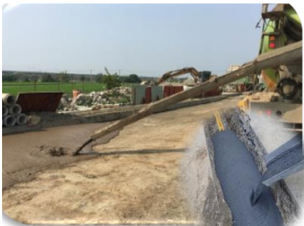
圖 6-12 控制性低強度混凝土再生綠建材
