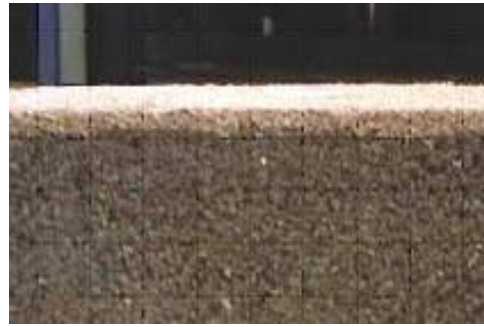
圖 7-22 透水性樹脂混合粒料之構造
