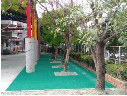
圖 7-7 現場整體澆置之剛性透水鋪面
