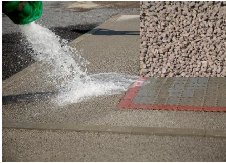
圖 6-10 再生粒料透水鋪面
