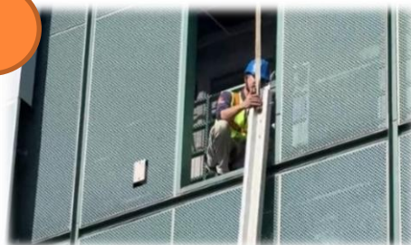
構件支架定位安裝
