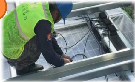
模組與接線組裝檢測
