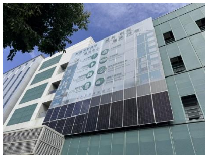
本所材料實驗中心 彩繪立面太陽光電
