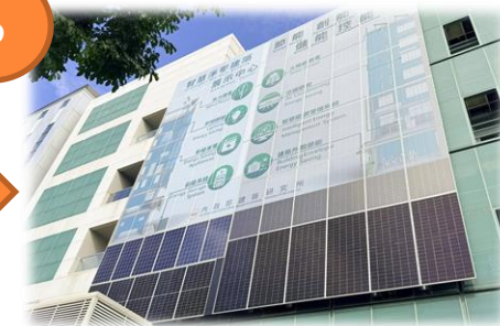
彩繪立面太陽光電建置完成
