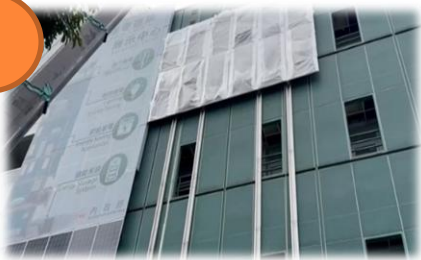
彩繪光電模組吊掛安裝
