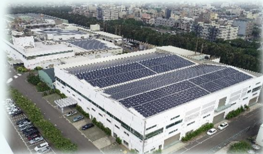
桃園市鋼鐵工廠1.8MW
